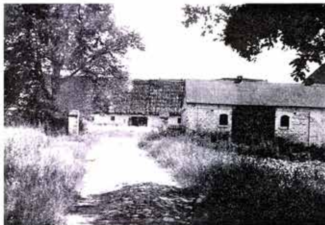
Wyreba 1987 r. - wjazd na folwark wg materiałów konserwatorskich
